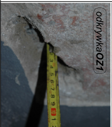
odkrywka prezbitorium -warstwa tynku zaciągnięta na polichromie
